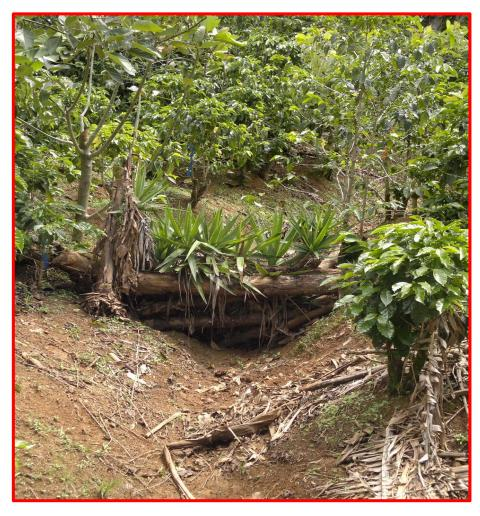
Las represas en los canales sirven para retener el suelo erosionado y la basura esto evita las avalanchas y derrumbes en la finca y permite re incorporar el suelo al mismo lote
